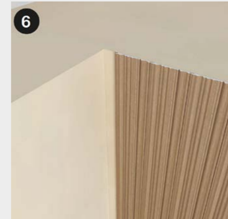
6 Mesurer l'espace restant entre l'avant-dernier panneau et l'angle intérieur, en tenant compte des joints. Messen Sie den verbleibenden Abstand zwischen der vorletzten Platte und der Innenecke unter Berücksichtigung der Fugen.
