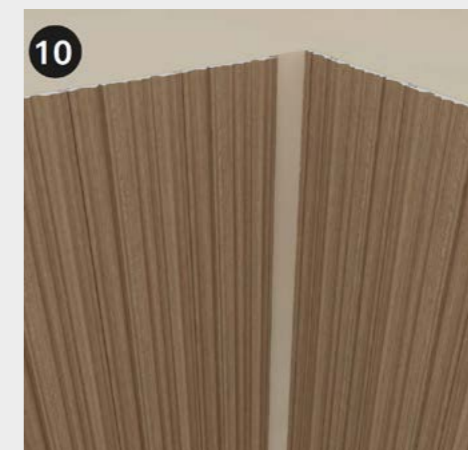
10 Installez les panneaux de l'autre côté du mur de la même manière que précédemment. Mesurer l'espace restant entre l'avant-dernier panneau et l'angle intérieur. Couper le panneau en fonction de la mesure obtenue. Montieren Sie die Platten auf der anderen Seite der Wand auf die gleiche Weise wie zuvor. Messen Sie den verbleibenden Abstand zwischen dem vorletzten Paneel und der Innenecke. Schneiden Sie das Paneel entsprechend dem ermittelten Maß zu.
