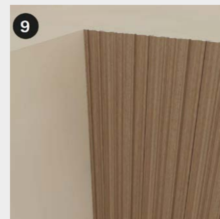
9 Installez le panneau coupé et appuyez dessus pour le mettre en place. Setzen Sie die zugeschnittene Platte ein und drücken Sie sie fest.
