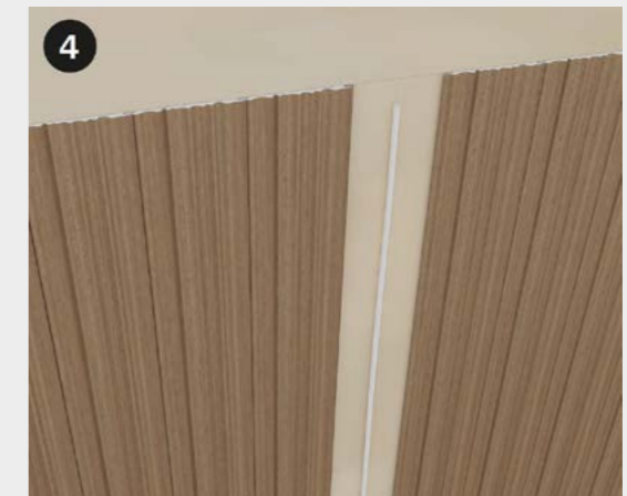
Enlever la colle murale résiduelle et en appliquer une nouvelle.
