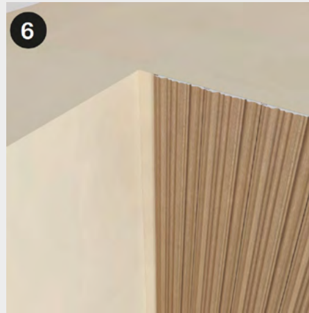
Mesurer l'espace restant entre l'avant-dernier panneau et l'angle intérieur, en tenant compte des joints.
