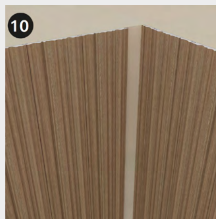
Installez les panneaux de l'autre côté du mur de la même manière que précédemment. Mesurer l'espace restant entre l'avant-dernier panneau et l'angle intérieur. Couper le panneau en fonction de la mesure obtenue.
