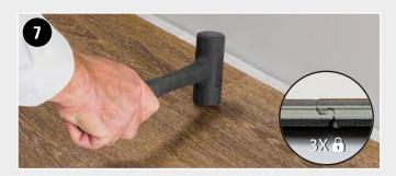
INSTALLEZ LA TROISIÈME DALLE SUR LE CÔTÉ COURT - 2 À l'aide d'un maillet en caoutchouc, tapez légèrement sur les coutures du petit côté pour les fixer. Cela permet un triple serrage.
