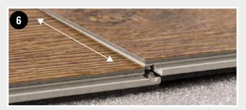
INSTALLEZ LA TROISIÈME DALLE SUR LE CÔTÉ COURT - 1 À l'aide du système de fixation breveté, abaissez le côté COURT de la dalle 3 pour qu'il corresponde au côté COURT de la dalle 1.
