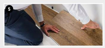
INSTALLER LA TROISIÈME DALLE SUR LE GRAND CÔTÉ Prenez une autre longue dalle (3). En répétant l'étape précédente, insérez le côté long de la dalle 3 dans le côté long de la dalle 2, puis faites glisser la dalle 3 vers la gauche jusqu'à ce que le côté COURT entre en contact avec le côté COURT de la dalle 1.
