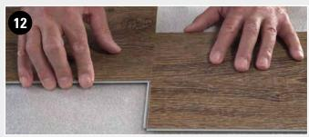
DÉMANTÈLEMENT DU CÔTÉ COURT Retirez la rangée en faisant glisser les dalles sur le petit côté.
