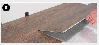
INSTALLATION À PARTIR DE LA QUATRIÈME DALLE Pour les rangs suivants, l'installation ne nécessite pas de rangs alternés. Installez rangée après rangée, en commençant par le côté long qui s'emboîte, jusqu'à ce que les côtés courts entrent en contact.
