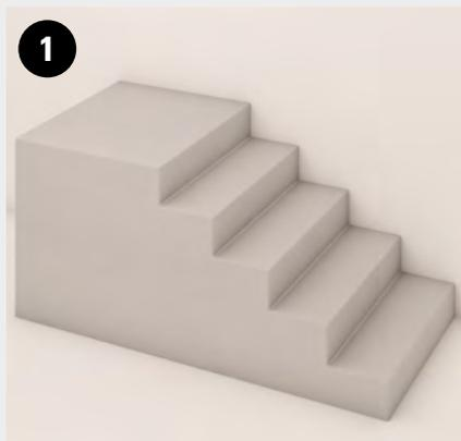
1 Prüfen Sie die zu beschichtenden Stufen; ihre Oberfläche muss glatt, eben, trocken und staubfrei sein.
