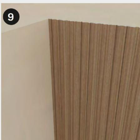
Setzen Sie die zugeschnittene Platte ein und drücken Sie sie fest.
