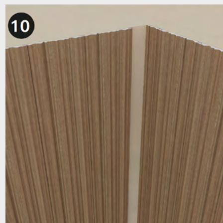
Montieren Sie die Platten auf der anderen Seite der Wand auf die gleiche Weise wie zuvor. Messen Sie den verbleibenden Abstand zwischen dem vorletzten Paneel und der Innenecke. Schneiden Sie das Paneel entsprechend dem ermittelten Maß zu.
