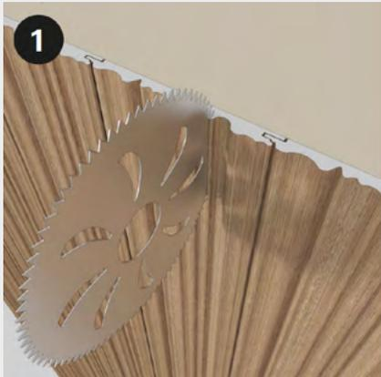
Die beschädigte Platte muss an zwei Stellen wie gezeigt ausgeschnitten werden.
