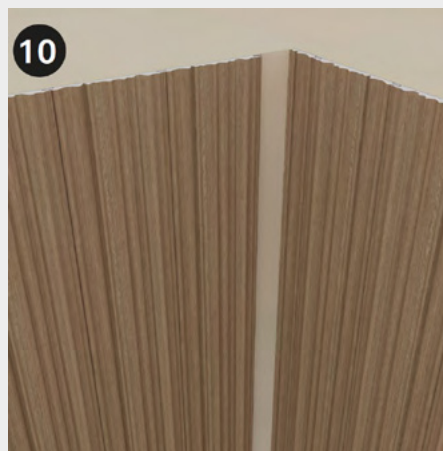
Installare i pannelli sull'altro lato della parete allo stesso modo dei precedenti. Misurare lo spazio rimanente tra il penultimo pannello e l'angolo interno. Tagliare il pannello secondo la misura ottenuta. Install the panels on the other side of the wall in the same way as the previous ones. Measure the remaining space between the penultimate panel and the inside corner. Cut the panel according to the measurement obtained.
