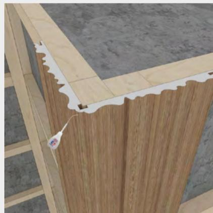
Dopo aver rivestito gli angoli esterni, applicare con cura della colla tipo Super Attack in corrispondenza del punto di giunzione dei due profili. Se viene applicata troppa colla, rimuoverne l'eccesso immediatamente con un panno pulito e asciutto.
