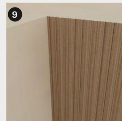
9 Installare il pannello tagliato e pressarlo per fissarlo in posizione.
