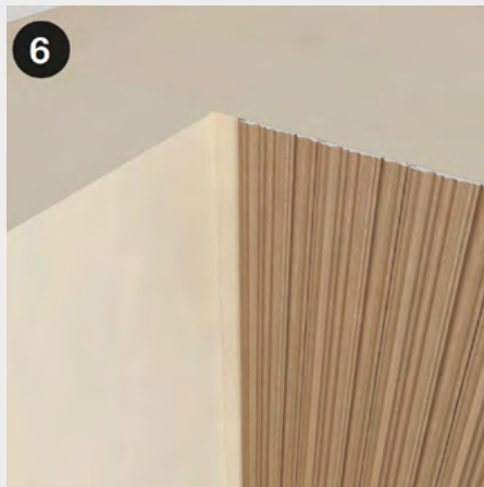
Misurare lo spazio rimanente tra il penultimo pannello e l'angolo interno, considerando gli incastri.
